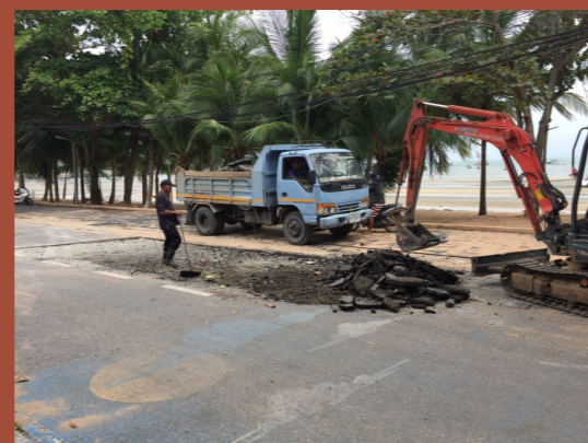
งานขุดซ่อม
